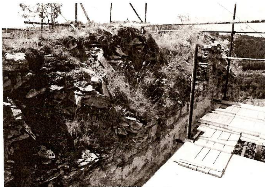
Pohled na dokončenou korunu zdiva v roce 2002 s uchyceným drnem a travinami a ukázka zajištění koruny před násypem jílu, hlíny a pokrytím drny v roce 2003, detail vnější části koruny východní hradby, foto: archiv Sboru, R. Dušek, 2002, 22.8.2003
