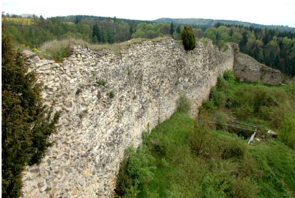
Vnitřní stěna plášťové hradby z vyhlídkové plošiny, pohledově zdařilé zajištění včetně koruny zdiva, foto R.Dušek, 2014
